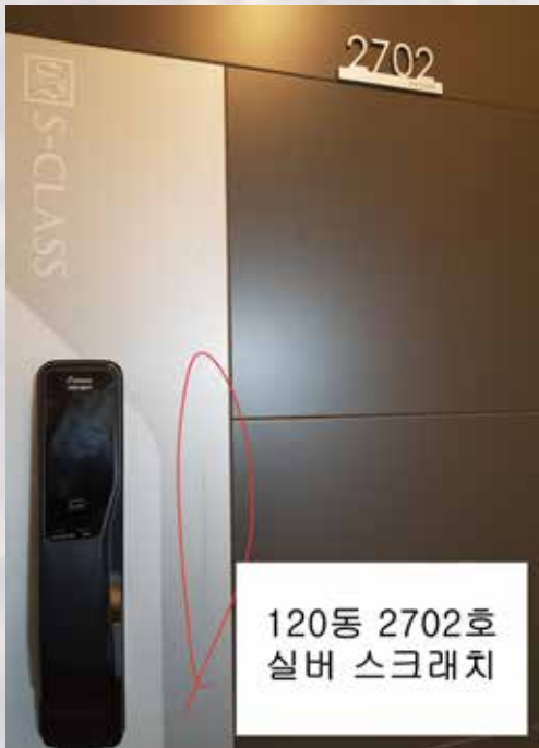
실버 비드판 보수 전
