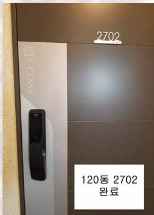
실버 비드판 보수 후
